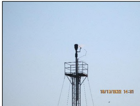
รูปที่ 2-31 ปล่องเผาก๊าซในแนวตั้งของฐานหลุมผลิตสังขาย
