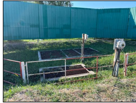
รูปที่ 2-28 ระบบ API Separator /Oil interceptor
