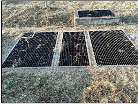
รูปที่ 2-28 ระบบ API Separator /Oil interceptor
