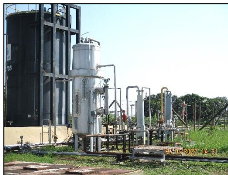
รูปที่ 2-32 เครื่องดักอนุภาคไฮโดรคาร์บอน (Flare Knock out Drum) ของฐานหลุมผลิตสังขาย
